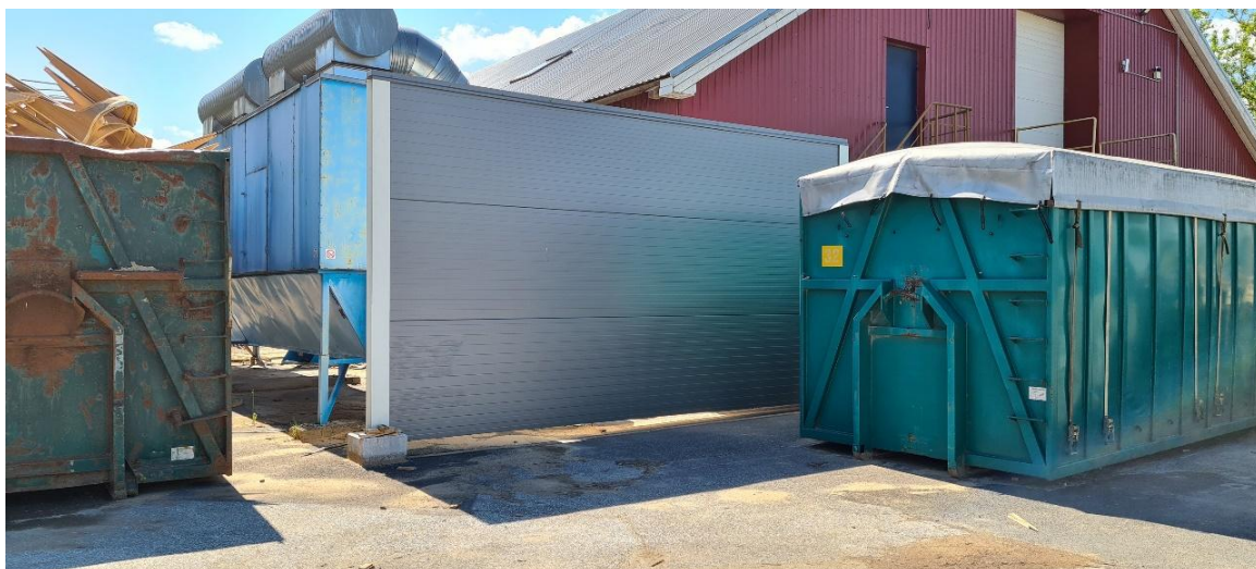
Foto 3. Soojuse tee 18 aspiratsiooniseade ja selle ees olev ekraan, mõõtmispunkt nr. 8
